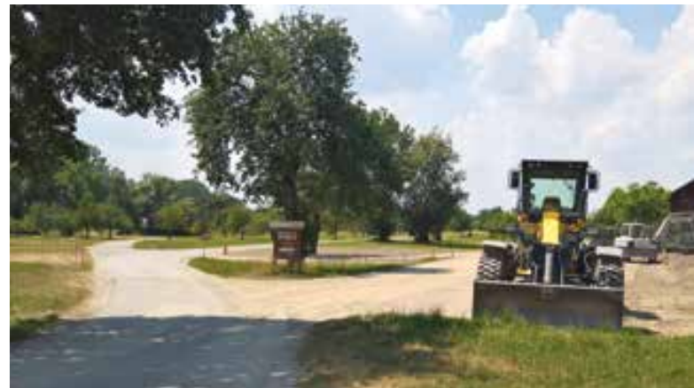
2018 – Baumaschinen beginnen mit der Herstellung der Zufahrtsstraße für die Ruder-WM2019
