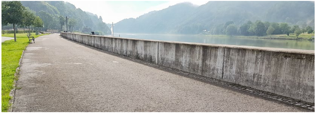
Grein: Geradlinig geführter, mobiler Hochwasserschutz in Grein, direkt an der Donau
