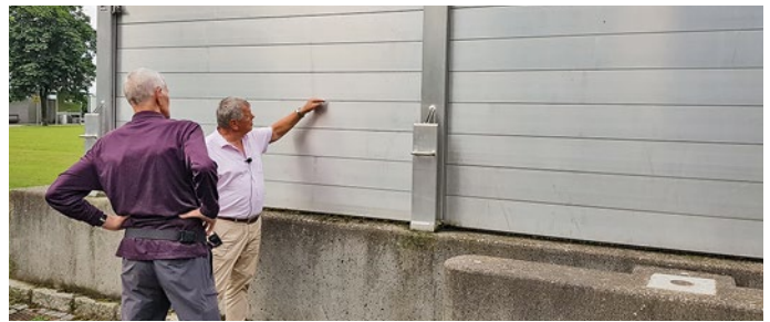
Persenbeug: Bürgermeister Mitmasser erklärt den mobilen Hochwasserschutz
