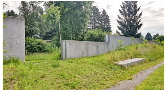
Persenbeug: fixe, hohe Mauern, mit Unterbrechungen für mobilen Hochwasserschutz
