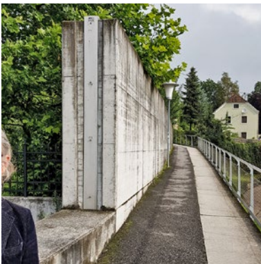
Grein: Fixe Mauer entlang des Greinerbachs (Zufluss zur Donau)
